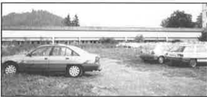
Die Schule für viele unter euch von einem ungewohnten Blickwinkel aus gesehen (Südansicht). Das Anwesen davor wurde kürzlich niedergezogen. (dzt. noch Grasparkplatz!)
